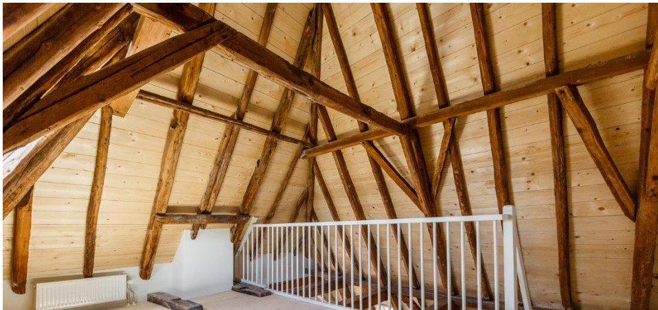
Voorbeeld van beschoten dakbeschot met g-g- delen
