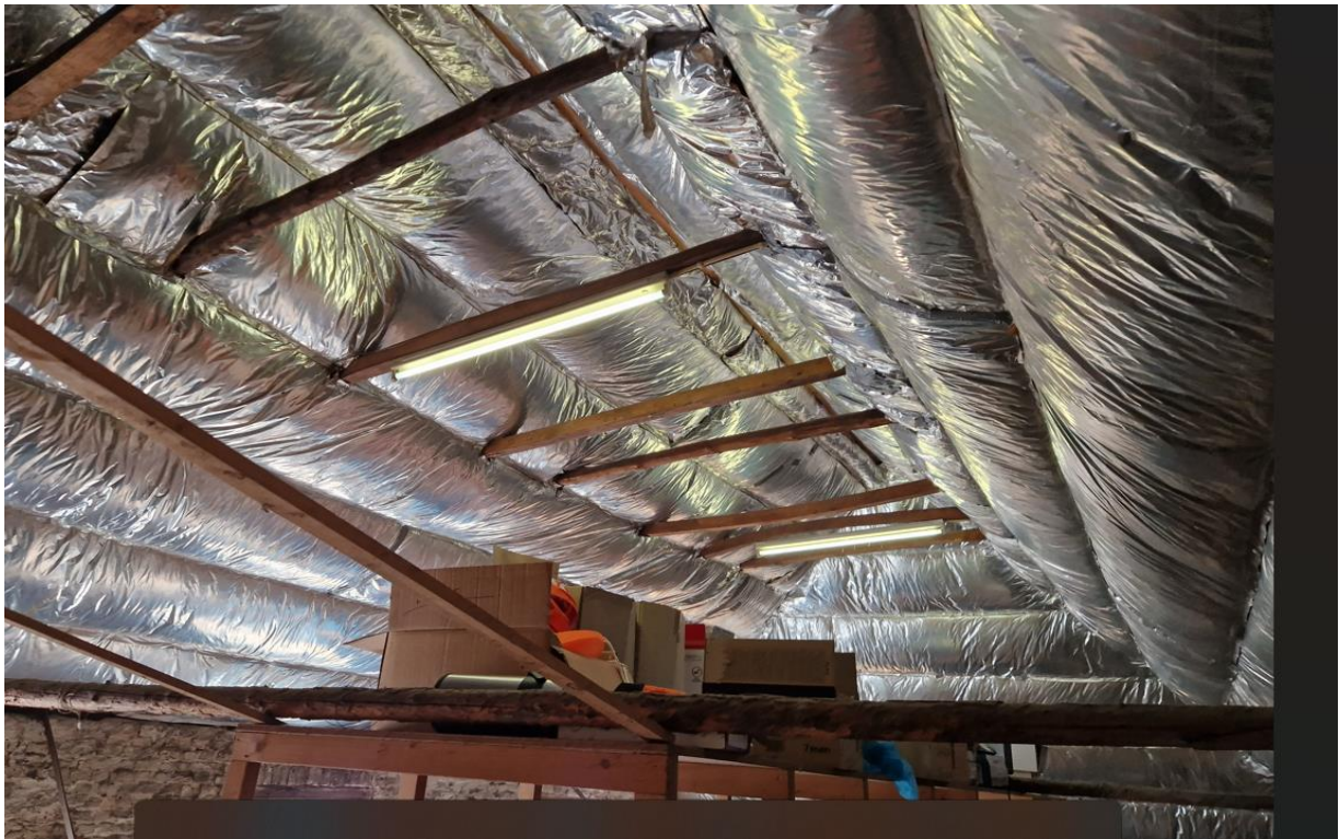
Figuur 1 Huidige kapconstructie
